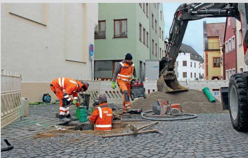
Die Stadtwerke Abensberg werden in diesem Jahr Kanalsanierungsarbeiten durchführen.
