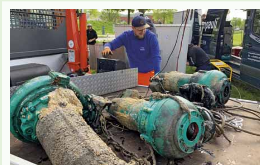
Im Bild oben Kläranlagen-Mitarbeiter Stefan Mayer bei den ausgebauten Schmutzwasserpumpen. Rechts ein Blick in den Pumpenschacht.
