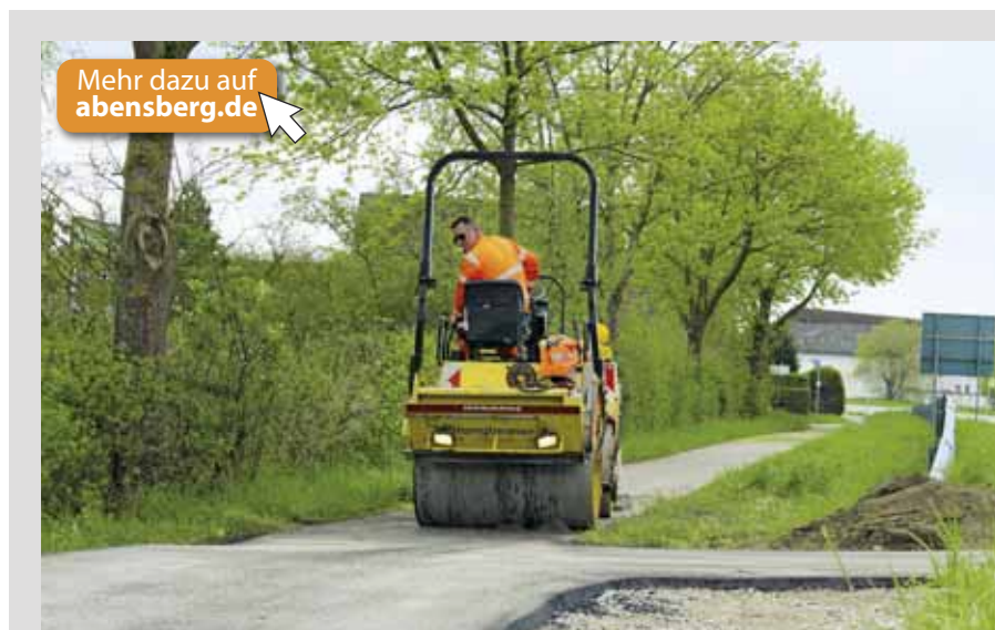
Ende Mai wurde die Umfahrung der Baustelle zur Errichtung eines Kreisverkehrs für den Verkehr freigegeben. Hier noch Asphaltierungsarbeiten.
